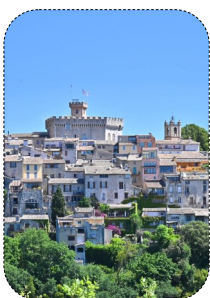
01 Les façades enduites
