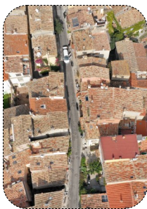
12 Les toitures en tuiles canal
