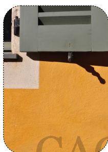
02 Les finitions d'enduits
