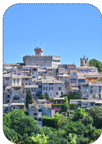
01 Les façades enduites
