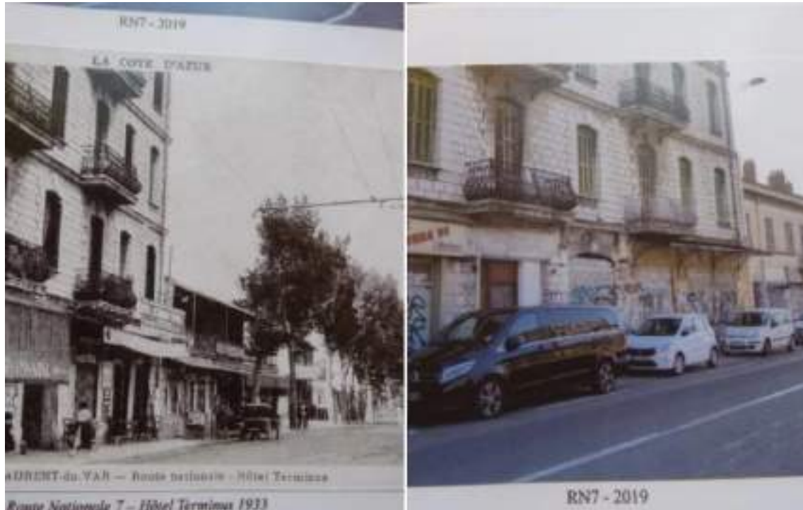
L'état de la RM6007 après un siècle
