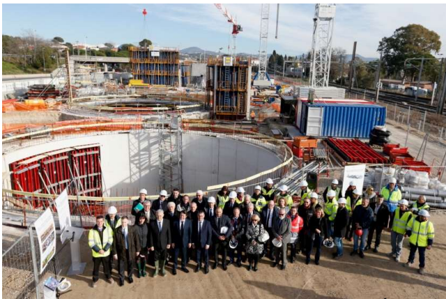
Visite du chantier par C. Estrosi et les élus - Janvier 2018
